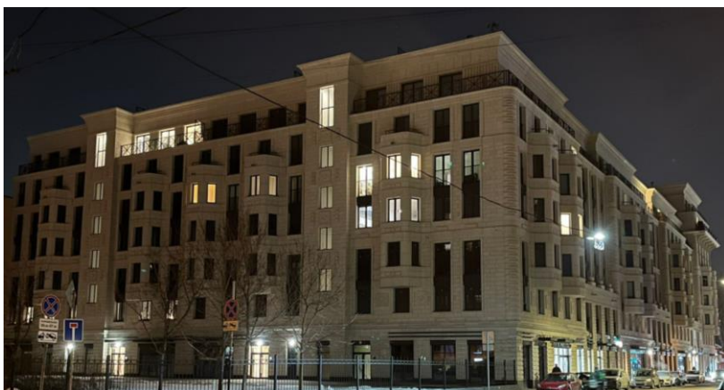
Фасад со стороны Тележной улицы
